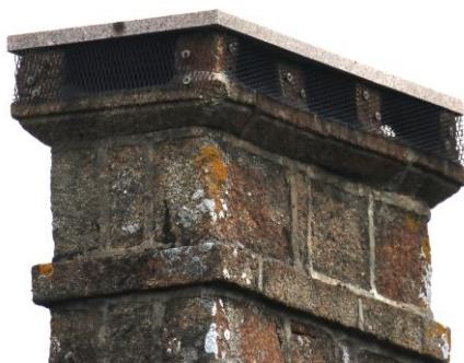
Figure 9 : Cheminée protégée par une grille épaisse
